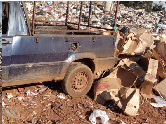
Veículo particular encontrado no local, descarregando recicláveis no perímetro da célula em uso. Tal situação indica falha no controle de fluxo de veículos e visitantes e prejudica o gerenciamento qualitativo dos resíduos depositados.
