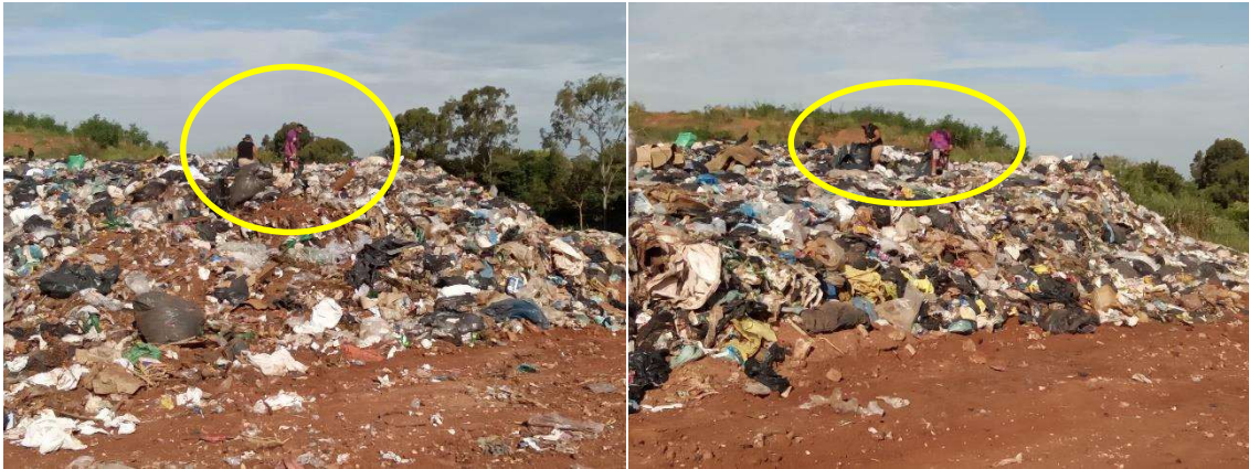
Presença de catadores de recicláveis atuando sobre os resíduos domiciliares depositados, indicando falha no controle e na coibição de acesso e desempenho dessa atividade de forma irregular.
