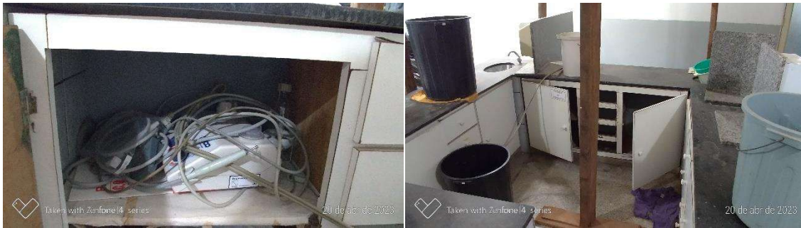
Aparelho de profilaxia e ultrassom, recentemente consertado, armazenado de forma imprópria em ambiente de reforma e com aparente risco de desabamento, além de vários pontos de gotejamento.
