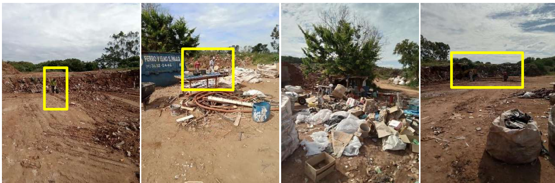
Triagem sendo realizada de forma manual, em virtude da suspensão do uso do equipamento de processamento de Resíduos de Construção Civil (RCC) e esteira.
